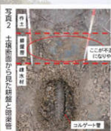
写真2 土壤断面から見た耕盤と暗渠管
